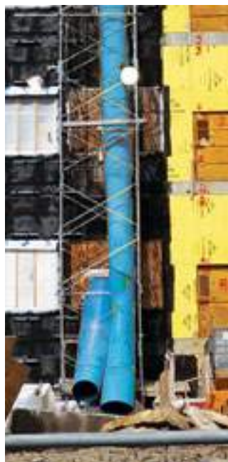
INSTALLATION TYPIQUE SUR CADRES D'ÉCHAFAUDAGES
